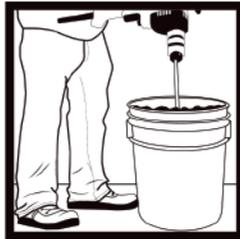
3. Mezclar de preferencia con taladro espada con revolvente hasta lograr una homogénea sin grumos. Ajustar agregando hasta 0,4 L de agua para lograr la consistencia deseada.
